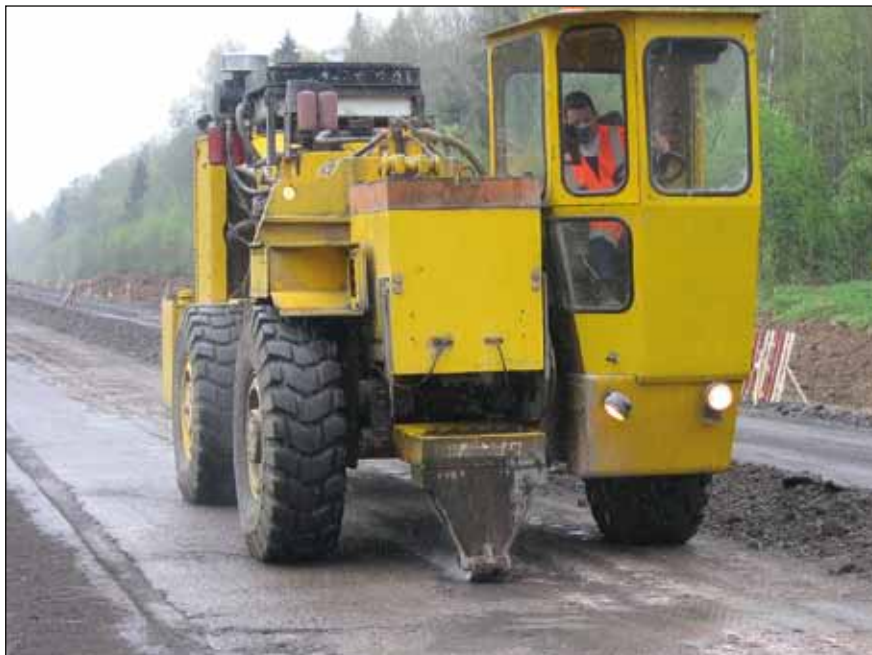
Рис. 8. Самоходная машина RB-500 фирмы RMI (США) с рабочим органом виброрезонансного разрушения монолитного цементобетонного старого покрытия
