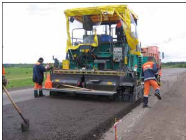
Рис. 7. Укладка в дорожное основание укрепленной асфальтобетонной крошки асфальтоукладчиком по струне
