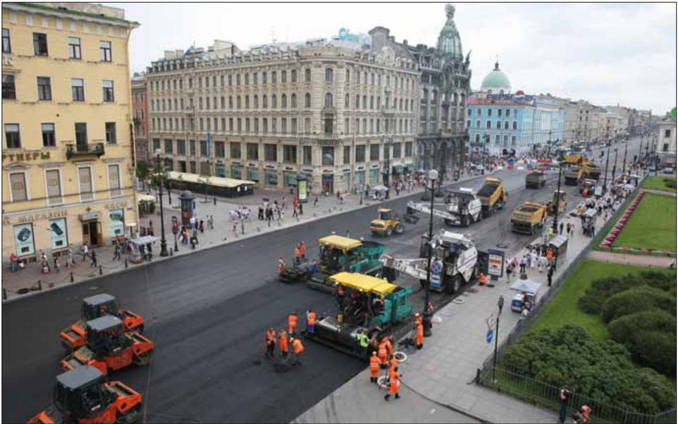
Рис. 16. Капитальный ремонт покрытия Невского пр. Санкт-Петербурга в 2008 году с укладкой асфальтобетона на половине его проезжей части
