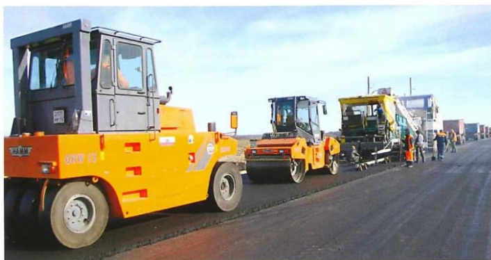
Участок новой автомобильной дороги Калининград-Зеленоградск
