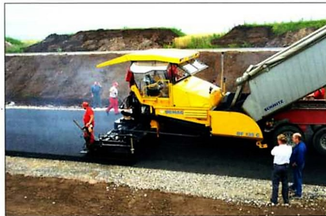
Асфальтоукладчики фирмы Deag (Германия) могут быть оборудованы выглаживающими плитами с газовым или электрообогревом.
