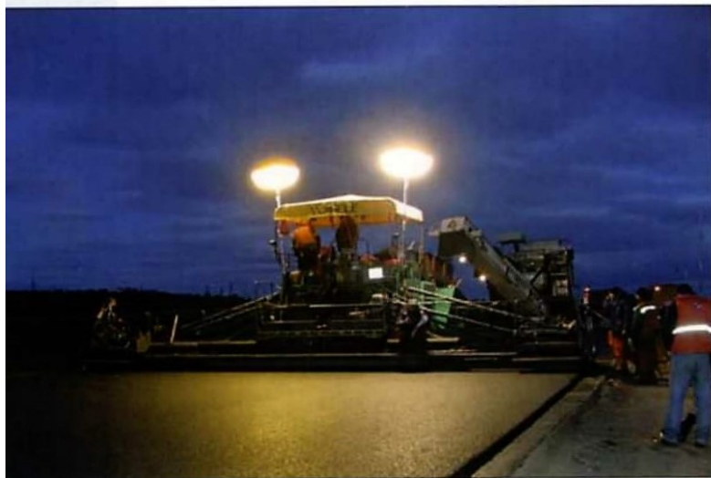
При чрезмерной дневной загрузке дороги транспортом, ЗАО «ВАД» выполняет укладку покрытия в ночное время.
