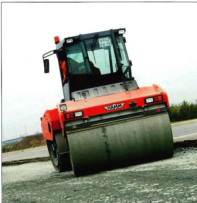
Рис. 3. Этап уплотнения щебеночного основания КАД Санкт-Петербурга тандемным виброкатком HD130 фирмы Hamm.
