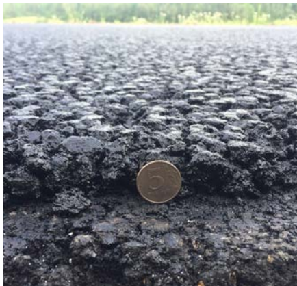
Рисунок 2. ММС-20 укладка тонким (3 см) слоем в Вологодской обл.; структура разрезанных гираторных образцов.
