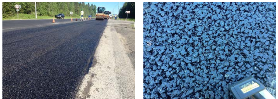
Рисунок 1. Первая укладка минерально-мастичной смеси (ММС-15). Вологодская обл., 3 июня 2015 г.
